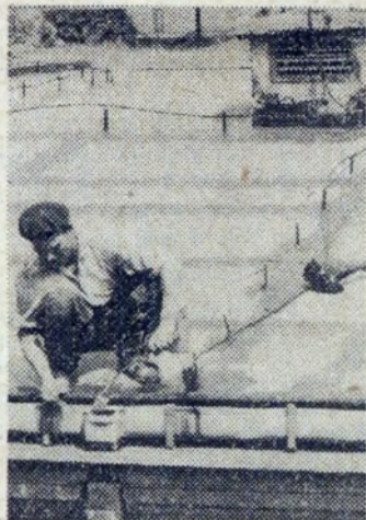
Aby dach nie przeciekał, należy go zabezpieczyć już teraz.
