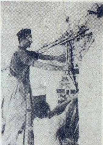
Zakładanie nowych instalacji w liceum, to ważna dla pracy w nowym roku szkolnym sprawa.
