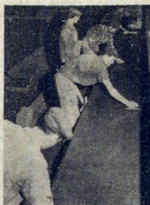
Szczególnie dużo pracy mają obecnie lastricarze. Wykonują schody na widowię.
