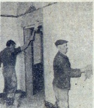
Do akcji wkroczyli już także fliziarze: pracują w pomieszczeniach basenu kąpielowego.
