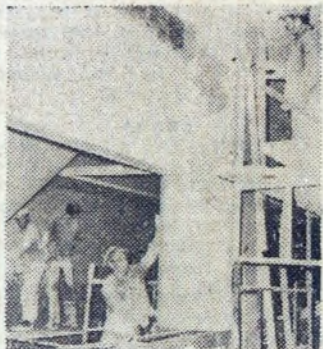
Brygada Jana Bałury (BPS) wykonuje wewnętrzne tynki.
