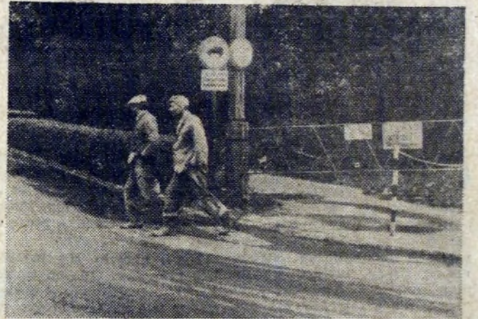
Jak długo jeszcze będzie zamknięty odcinek chodnika między Centralną Przychodnią a W-22T? Mimo licznych interwencji prace przebiegają opieszale, a przechodnie muszą przechodzić przez jezdnię na drugą stronę. Przy tak ruchliwej trasie, o wypadku nie trudno. Czekamy na odpowiedź od 1-6, które nadzorują roboty. J. ROŚKIEWICZ
