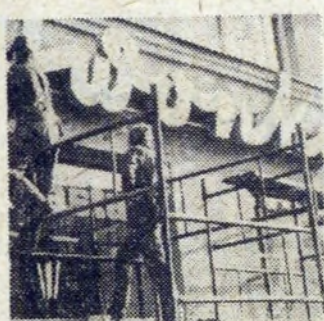
Przybywa również barwnych neonów. Na zdjęciu montaż neonowego oświetlenia reklamującego słodkie towary „Iwunki” na os. Słonecznym. Jedna uwaga: nie wystarczy neon założyć, trzeba dbać, aby nie mrugał i nie gasł.
