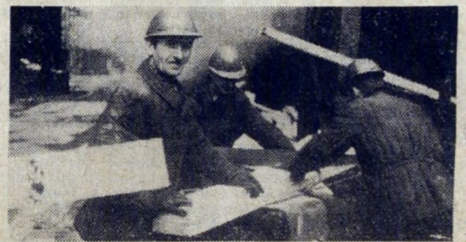
S. Bajda, M. Frydrychowski i S. Machejek przygotowują obudowę dla przenośnego transformatora — wszyscy z Hutniczego Przedsiębiorstwa Remontowego.
