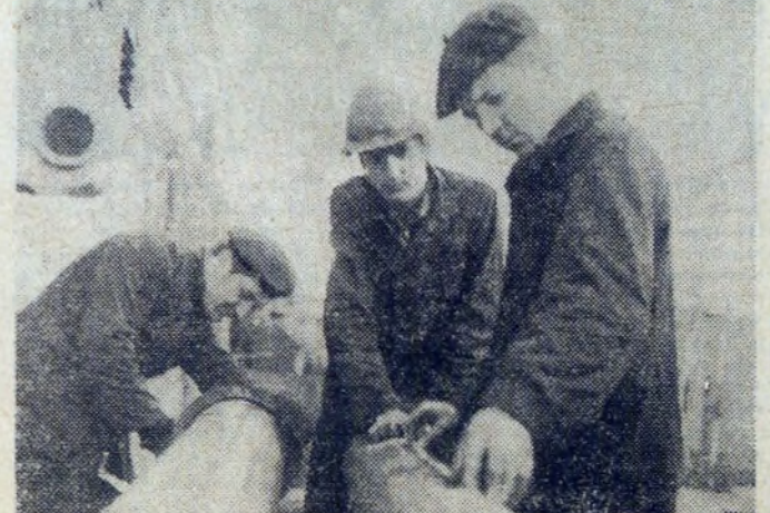
Tadeusz Sienlowski, Andrzej Kuźma i Henryk Kozera przy trasowaniu otworów w rurociągu wentylacyjnym. Fot. St. GAWLIŃSKI
