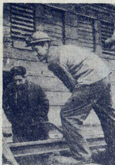
Prace torowe należą do najcięższych.
