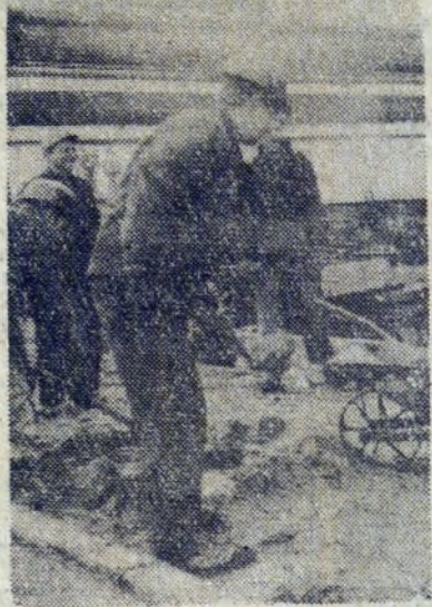
Dzięki czynowi pracowników ZRH droga dojazdowa obok wielkiego pieca nr 5 będzie gotowa wcześniej.
