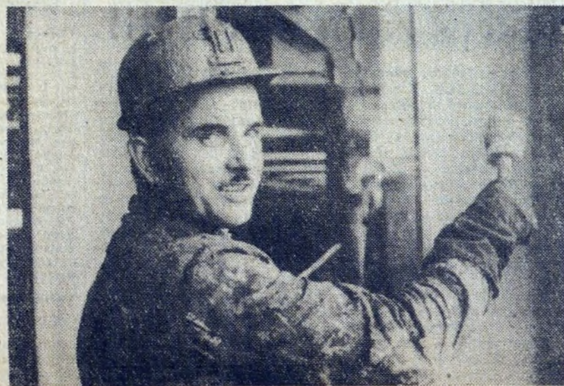
Czesław Porębski — malarz oddziału powłok antykorozyjnych — przy malowaniu konstrukcji hali peynowni.
