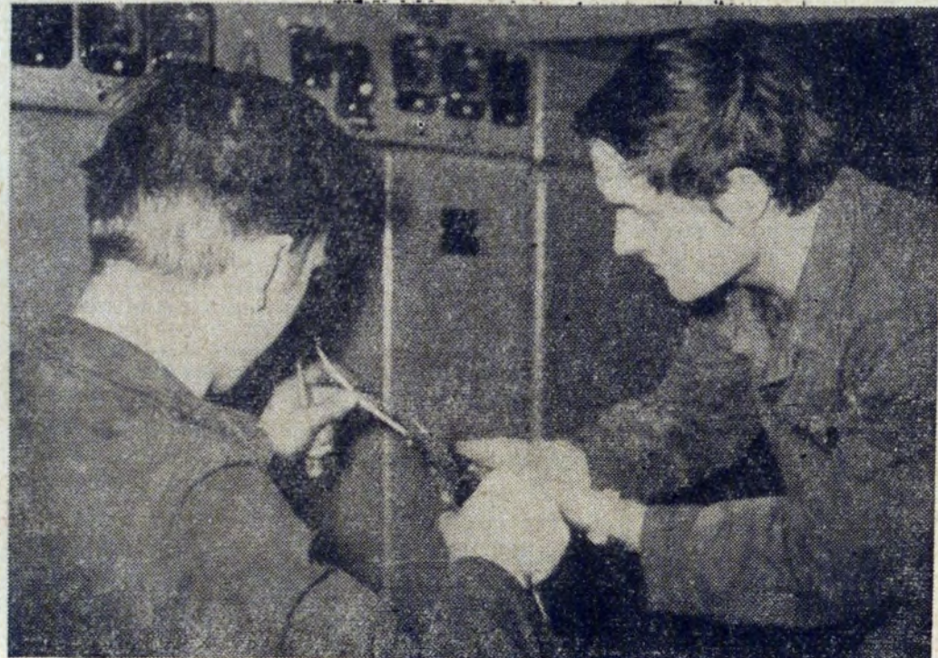
Walcownia Slabing: aparatura pomiarowa, to oczko w głowie dla elektryków A. Kowackiego i R. Kukowskiego. Fot. J. ROSKIEWICZ
