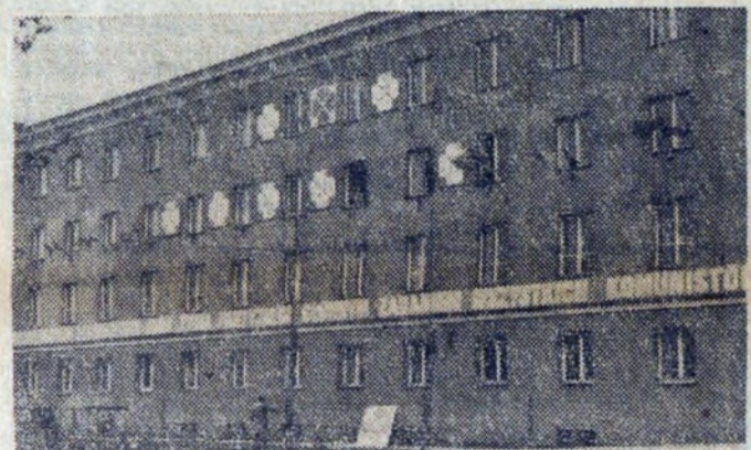
Budynek hotelowy DMH przy ul. Bulwarowej. Tutaj prace jeszcze trwały w chwili wykonywania zdjęcia.
