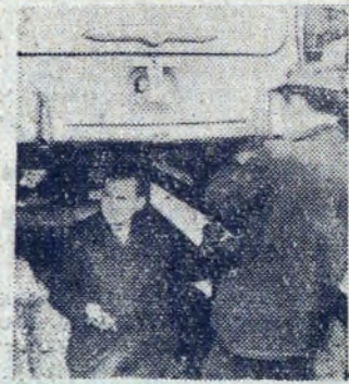
Na kanale naprawczym „Mosk-wicz”: umocowanie rury wydechowej.
