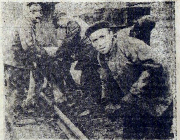
Brygada torowa nr 1 przy wymianie uszkodzonych szyn. Fot. S. GAWLIŃSKI
