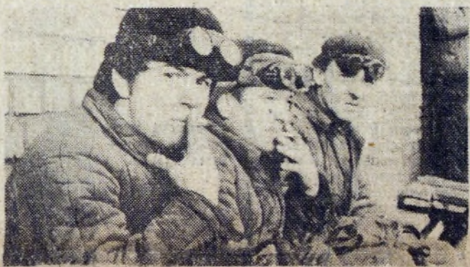
Na zdjęciu chwila przerwy w pracy budowlanych, dobrze zabezpieczonych przed mrozem. Foto: ST. GAWLIŃSKI
