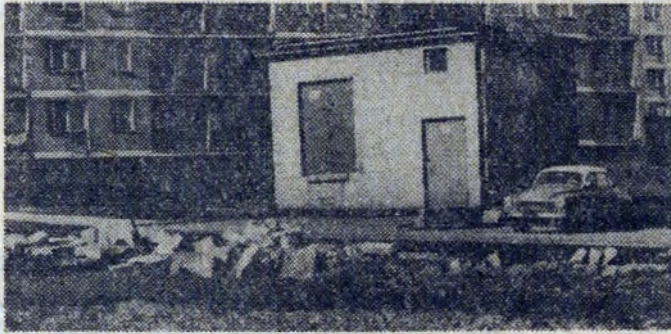
Na Stoku myślano chyba o ułożeniu chodnika, ale płyty leżą (niektóre już poniszczone) a robotników nie widać. Najwyższa już pora...
