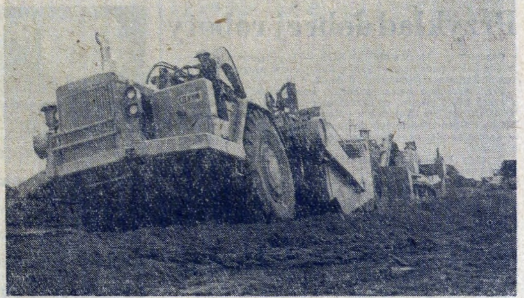
Dla potrzeb budowy huty „Katowice” zakupiliśmy w Wielkiej Brytanii potężne katarpile, które niwelują teren pod przyszłą budowę. Fot. J. PODLECKI
