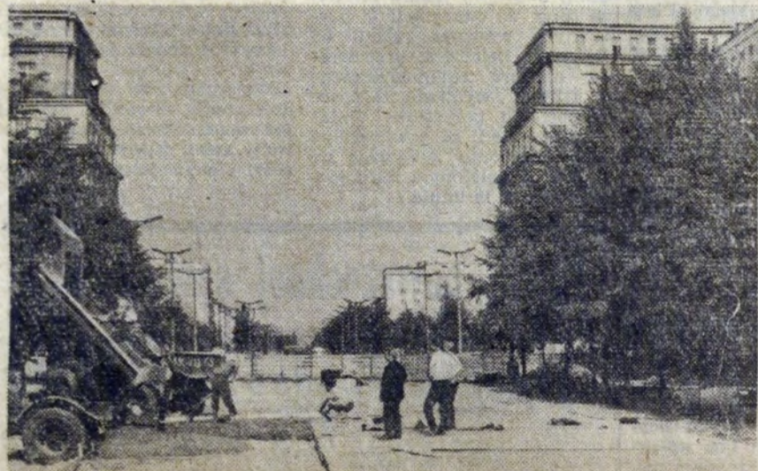
Na terenie budowy pomnika Lenina w alei Róż.
