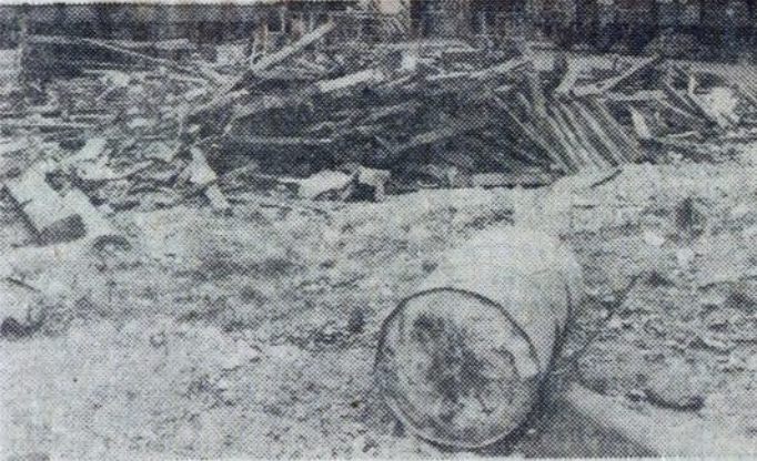
Pomiędzy torami kolejowymi nr 249 i 251, obok P-62 od strony wschodniej, o akcji porządkowej jeszcze nic nie słychać. Zresztą zdjecie mówi samo za siebie...
