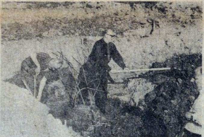
Przy budowie Domu Wędkarza.
