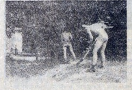
Praca przy wycieczaniu drogi
