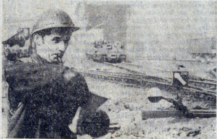
Manewrowy przy pracy.
