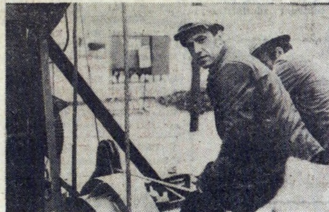
Przy wbijaniu ostatniego pala fundamentowego
