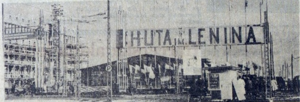
Budynek dyrekcji HiL w budowie.
