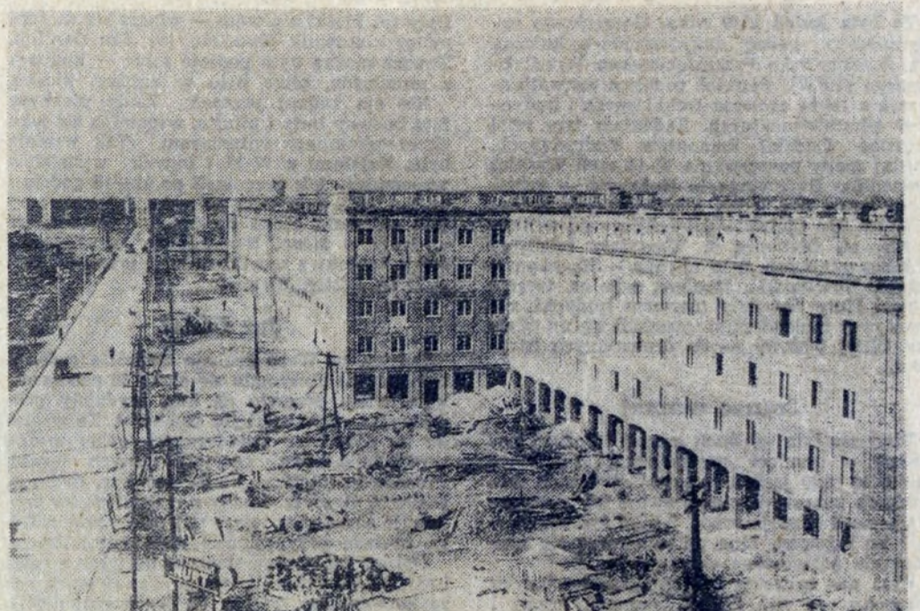
Widok na budujące się osiedle Teatralne — rok 1953.
