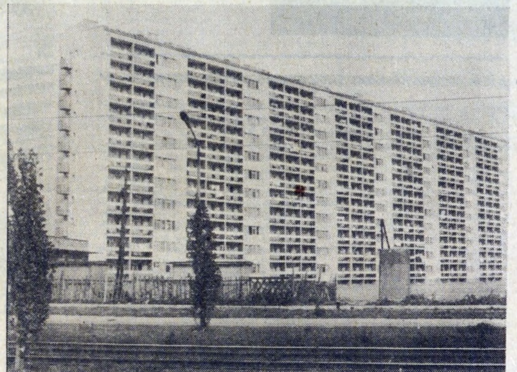
Efekt pracy budowniczych — jeden z nowych bloków mieszkalnych w Nowej Hucie,
