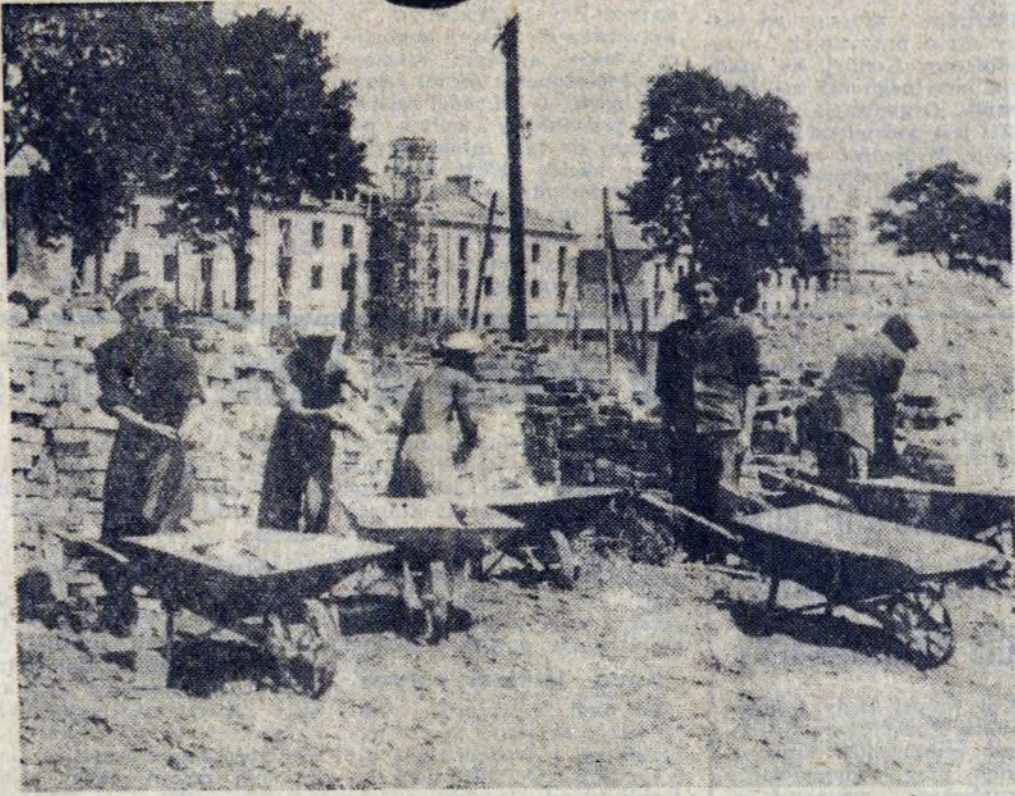
To zdjęcie wykonano prawdopodobnie przy budowie osiedla A-0, obecnie Na Skarpie. Może ktoś rozpozna na nim pracujących tu murarzy? Prosimy o kierowanie wszelkich informacji na ten temat do Redakcji „Głosu”. Za tydzień — następne zdjęcie archiwalne.
