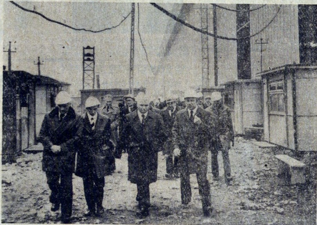
Wicepremier Alojzy Karkoszka wizytuje budowę Walcowni Blach Transformatorowych w Bochni.
