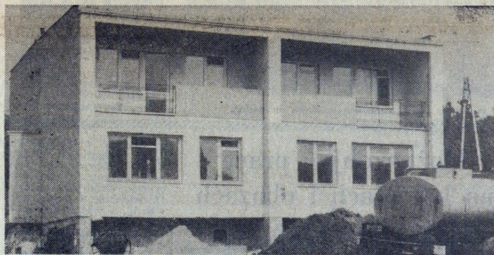
Na budowie domków jednorodzinnych dla hutników.
