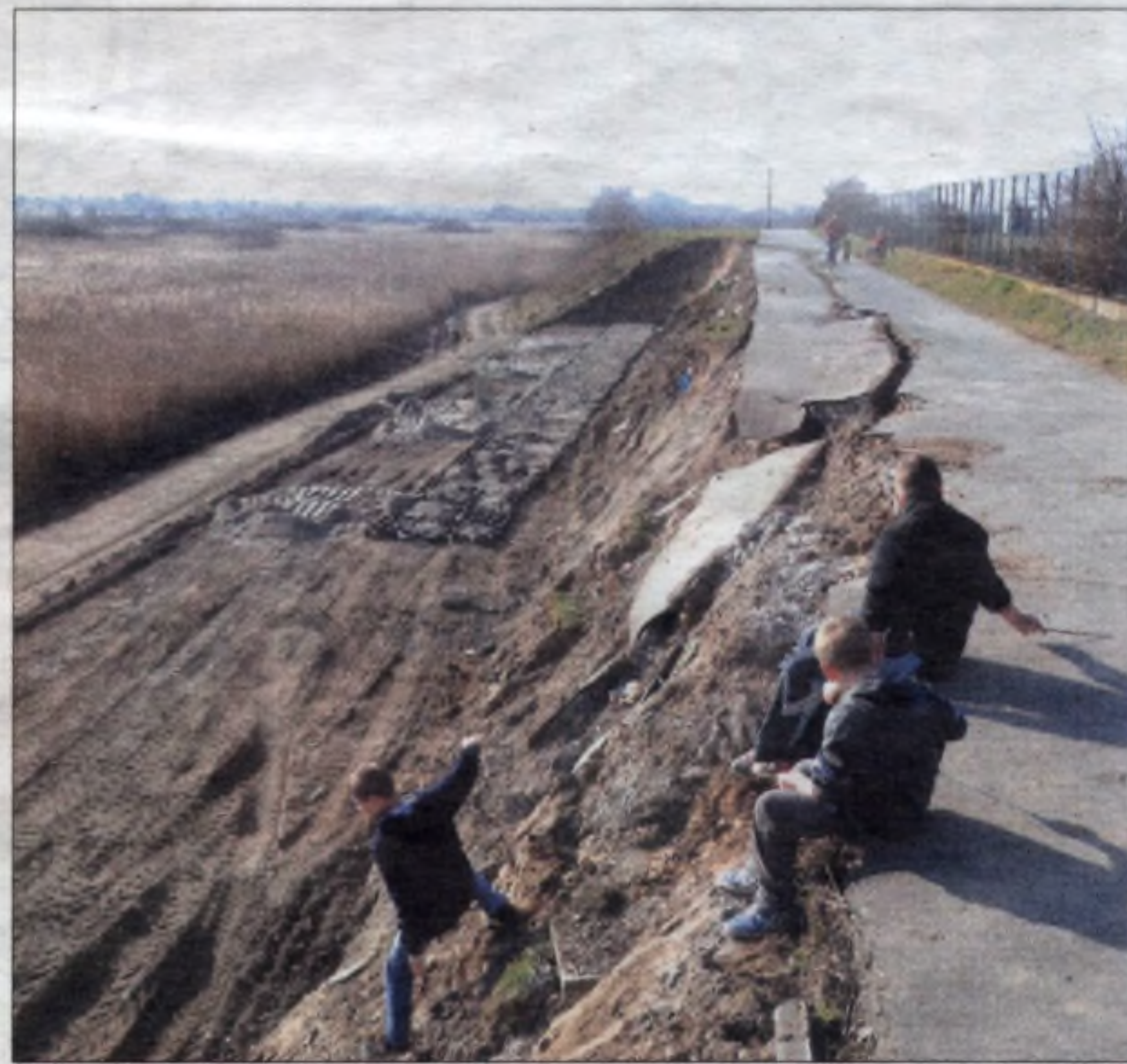
Fragment remontowanej nowohuckiej skarpy.
