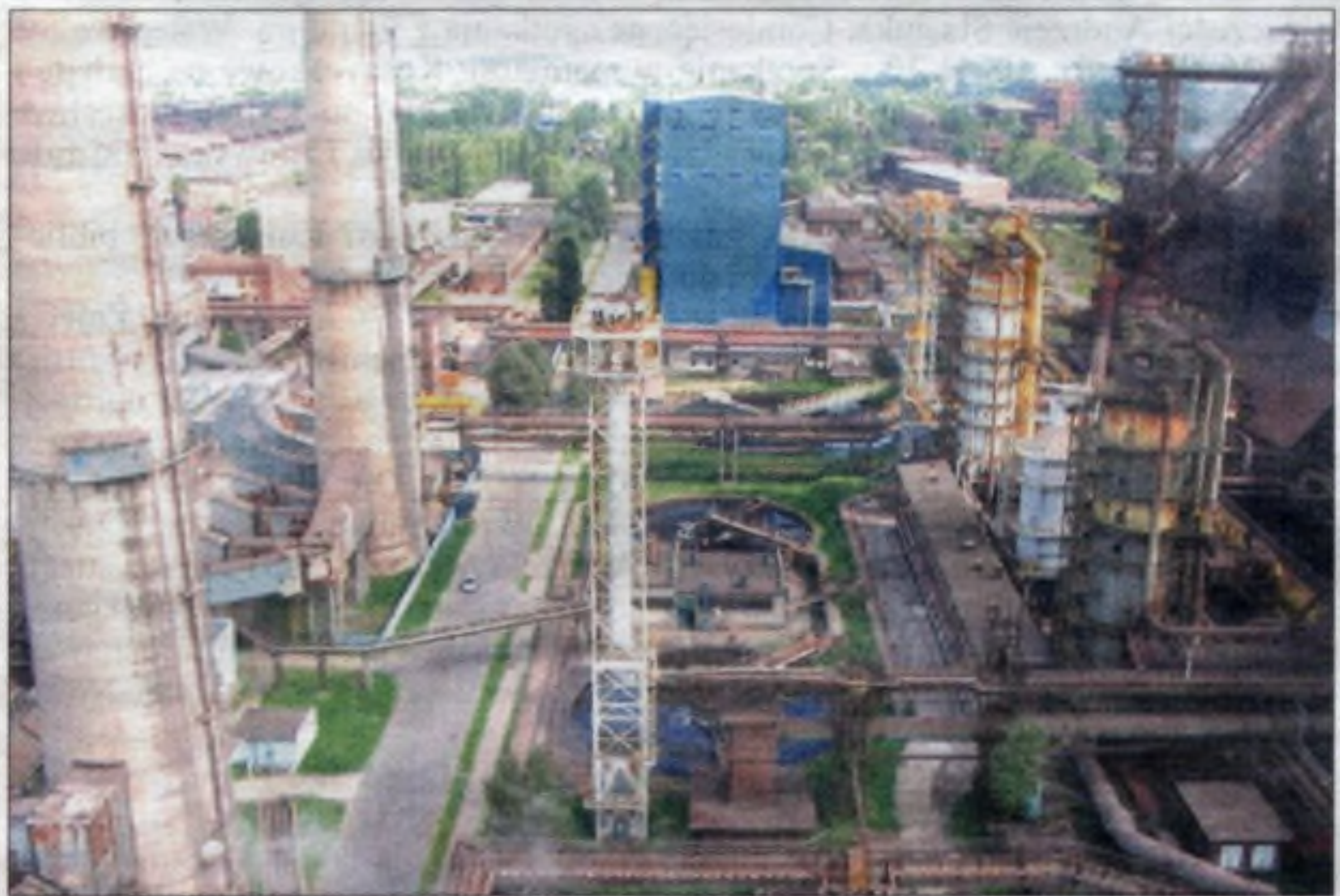
Woda wykorzystywana jest także w procesach produkcyjnych. Fragment obiegu chłodzącego wielkiego pieca.
