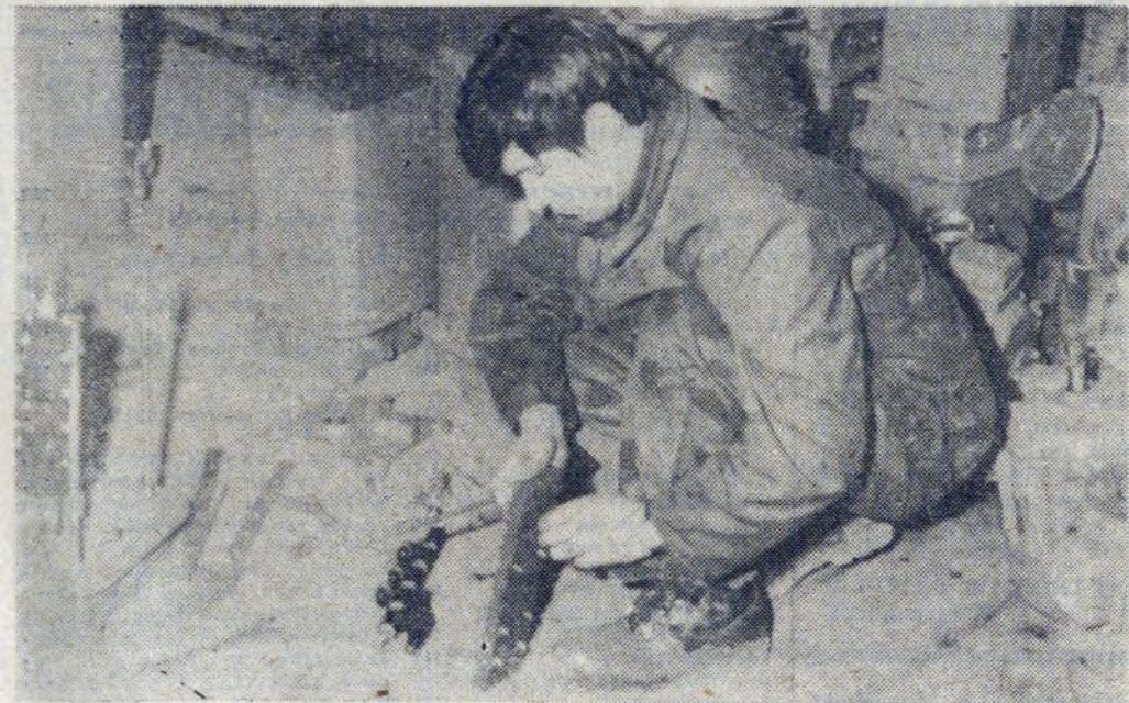
W warsztacie elektrycznym Wielkich Pieców Tadeusz Bajur remontował w ostatnia niedzielę szafę stycznikową. (Młodzieżowa Wiosna Czynów). Fot. S. GAWLIŃSKI
