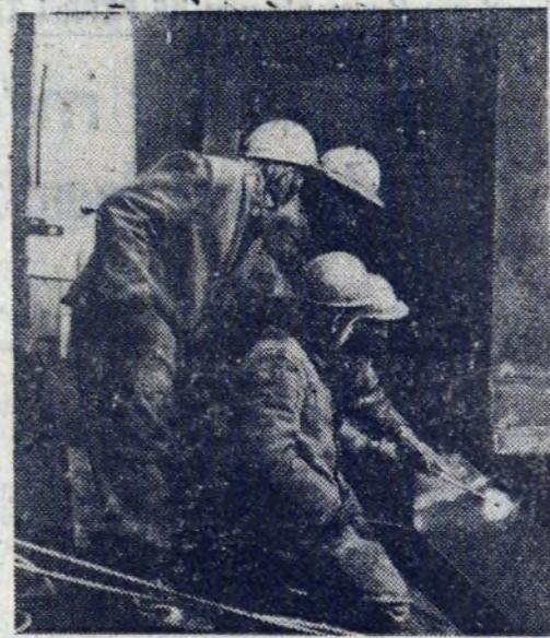
Młodzież z Zakładu Koksochemicznego przy remoncie maszyny wsadowej.
