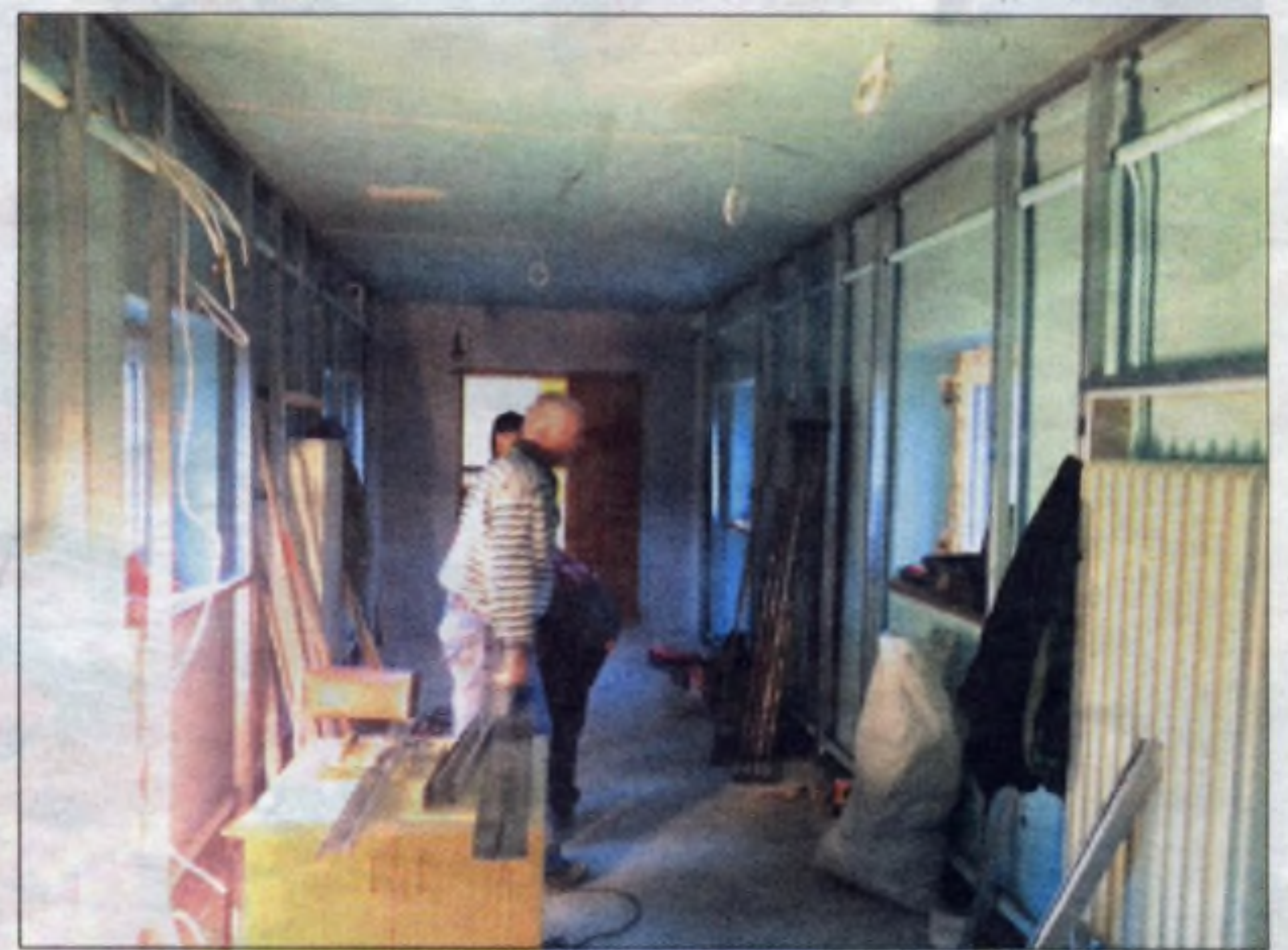
Prace remontowo-adaptacyjne w Szpitalu Żeromskiego.
