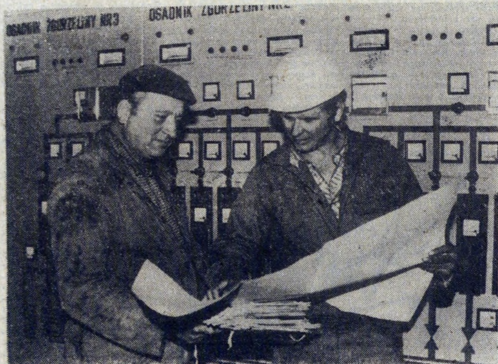
Pracownicy w trakcie montażu szafy rozdzielczej.
