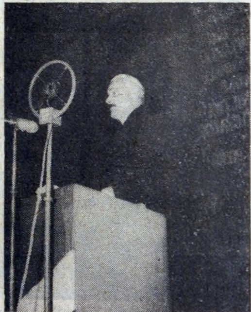
Dyrektor naczelny budowy huty inż. Jan Anioła podczas uruchomienia pierwszego obiektu — hali konstrukcji stalowych, w grudniu 1951 roku.
