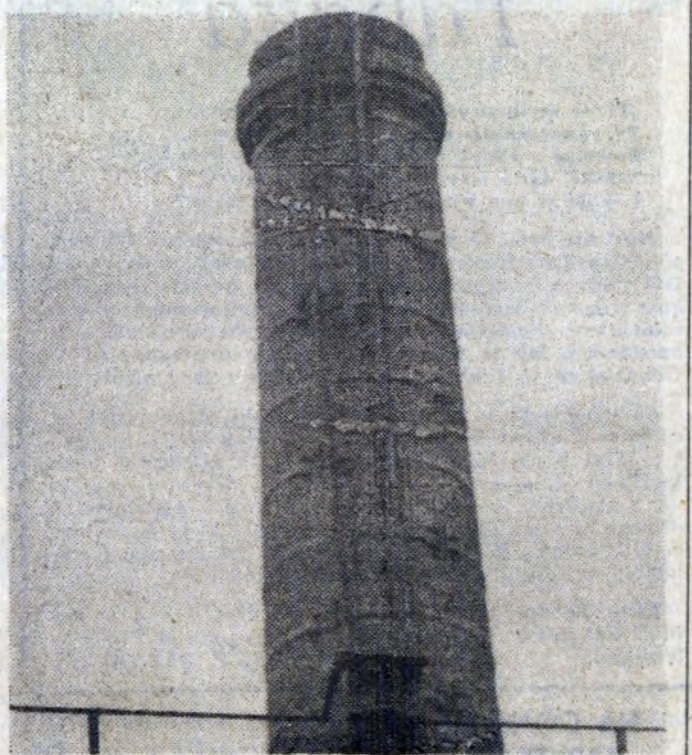
W takiej budce ptaki czują się dobrze nawet w sąsiedztwie hutniczych kominów... Fot. JACEK WCISŁO
