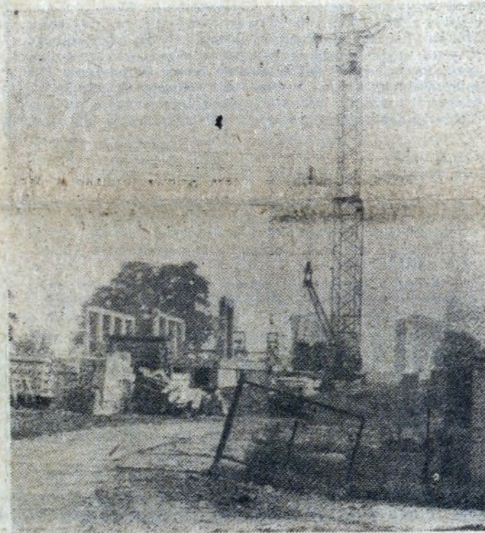
Na placu budowy nowej szkoły w Mistrzejowicach
