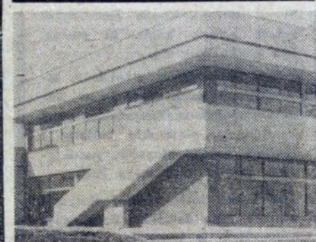
W os. Bohaterów Września wybudowano nowy pawilon handlowy. Fot.: S. GAWLIŃSKI
