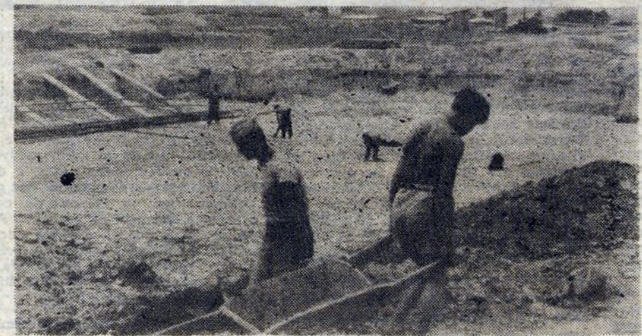
Junacy przy wykopach pod wielki piec, nr 1
