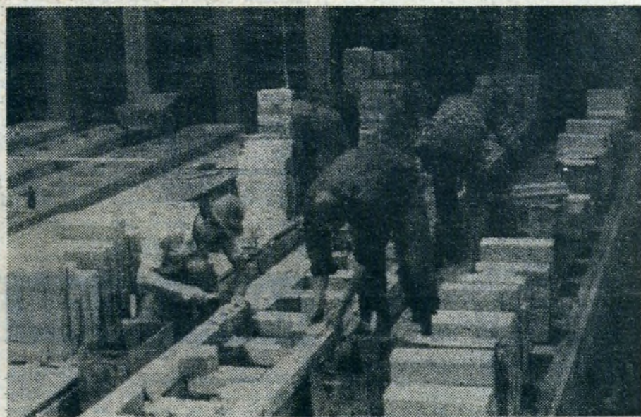
Biały murarze z krakowskiego „Piecbudu” przy budowie ścian grzewczych baterii koksowniczej nr 2. Fot. STANISŁAW GAWLIŃSKI
