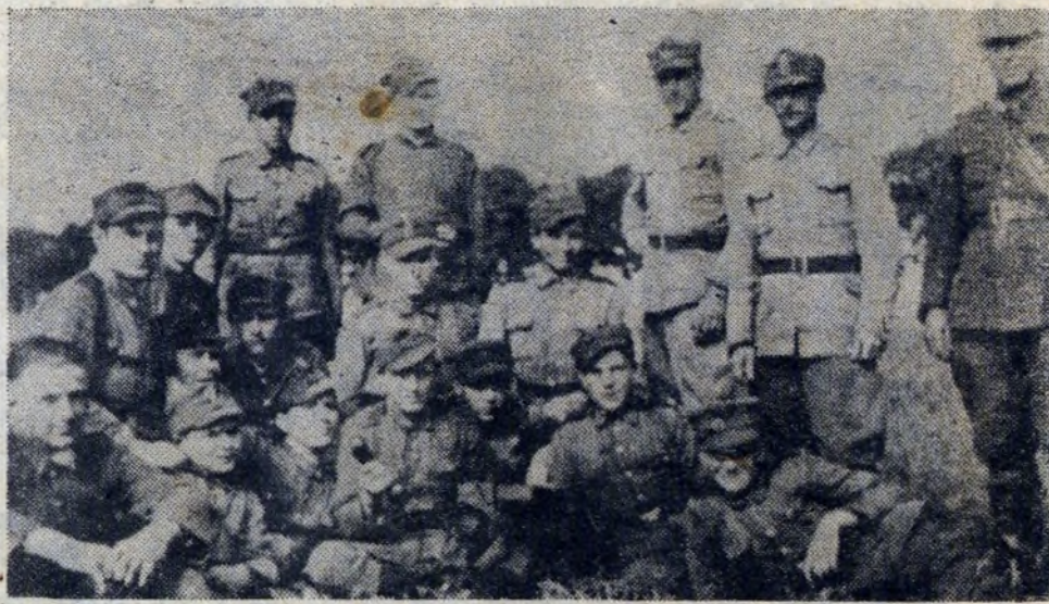
Żołnierze 6 DP przed wyruszeniem na front. Przerwał — październik 1944 r.
