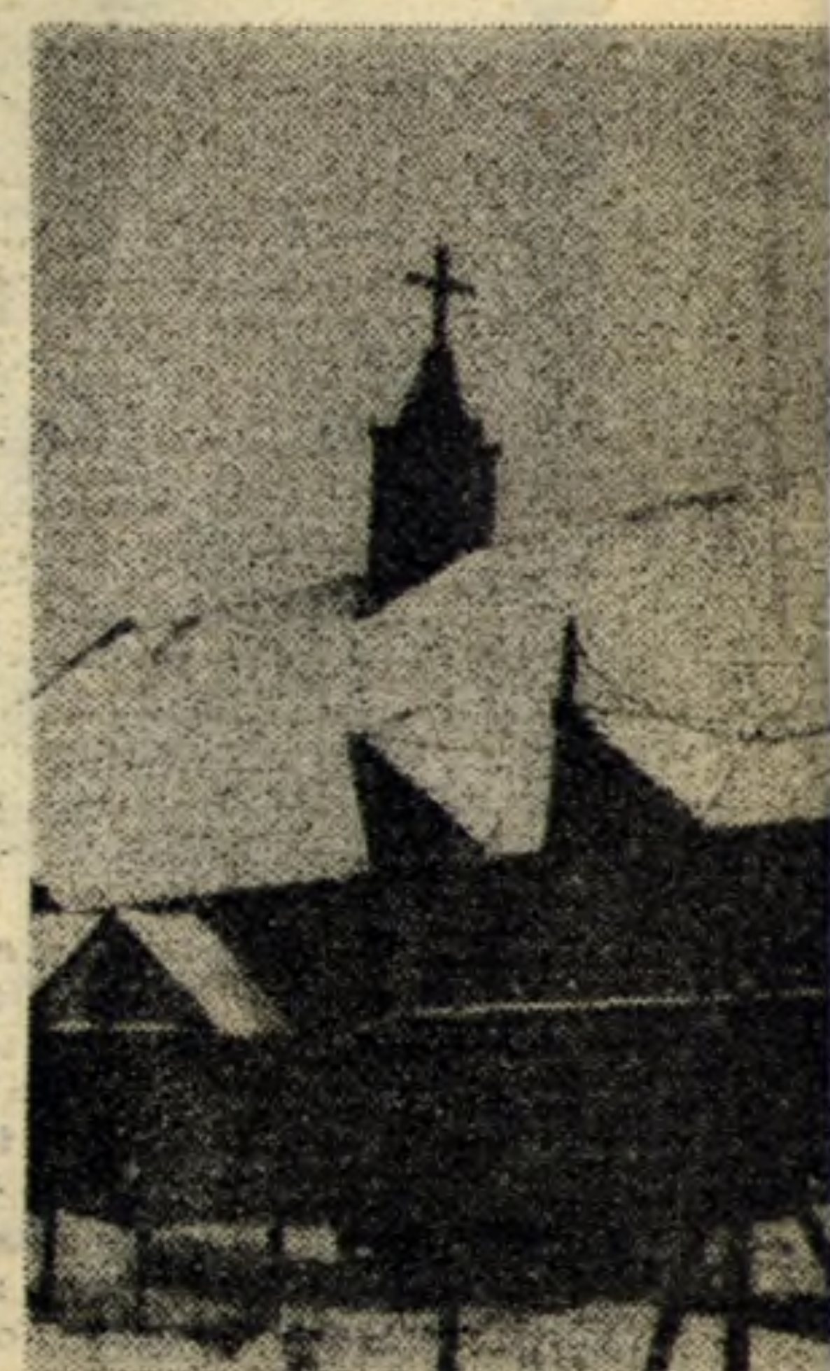
Na budowie kościoła Matki Bożej Materów Września.
