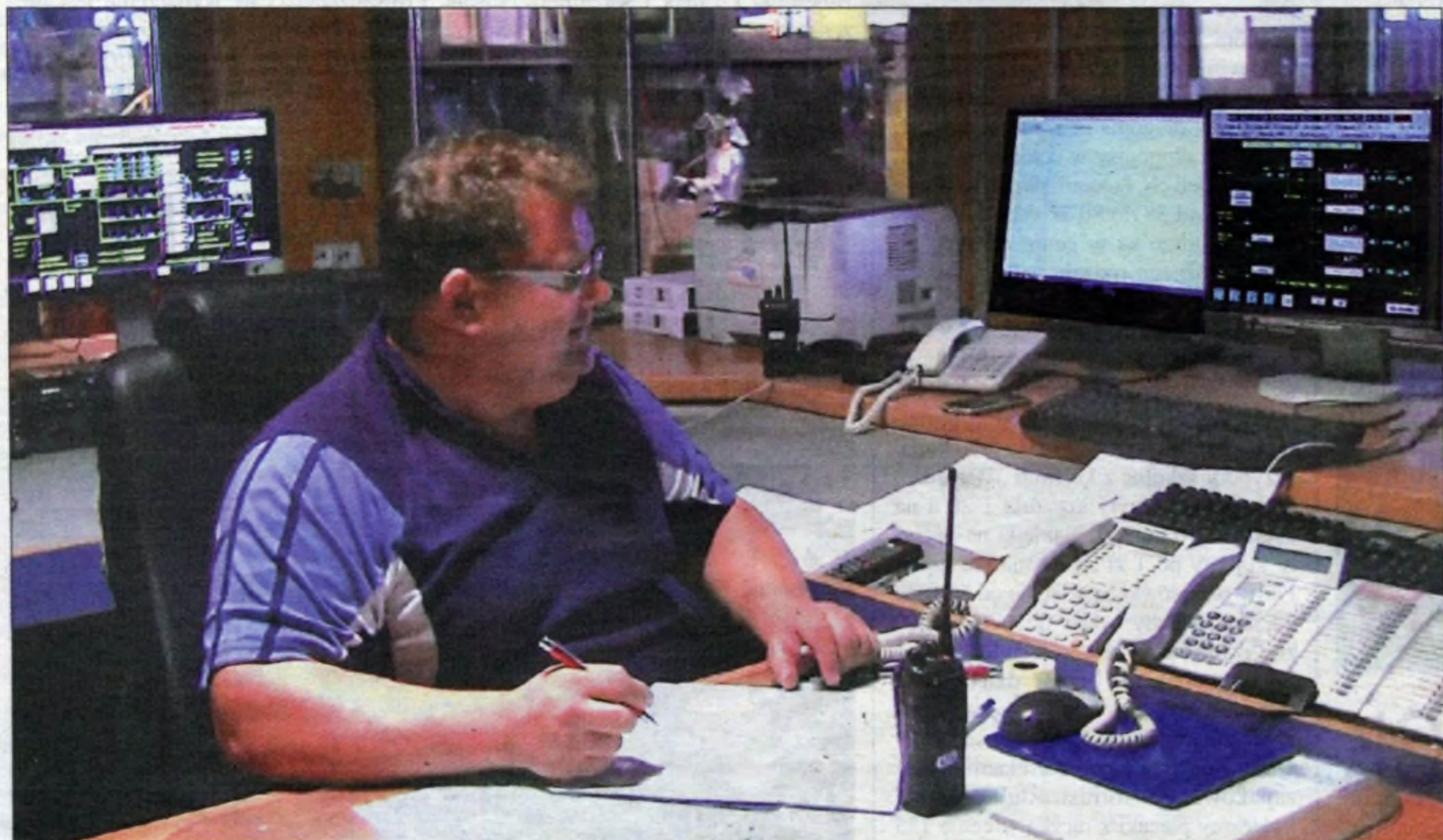
W klimatyzowanym pomieszczeniu, przy głównym pulpicie sterowniczym maszyny ciągłego odlewania stali (COS) pracuje operator Zbigniew Błaut.
