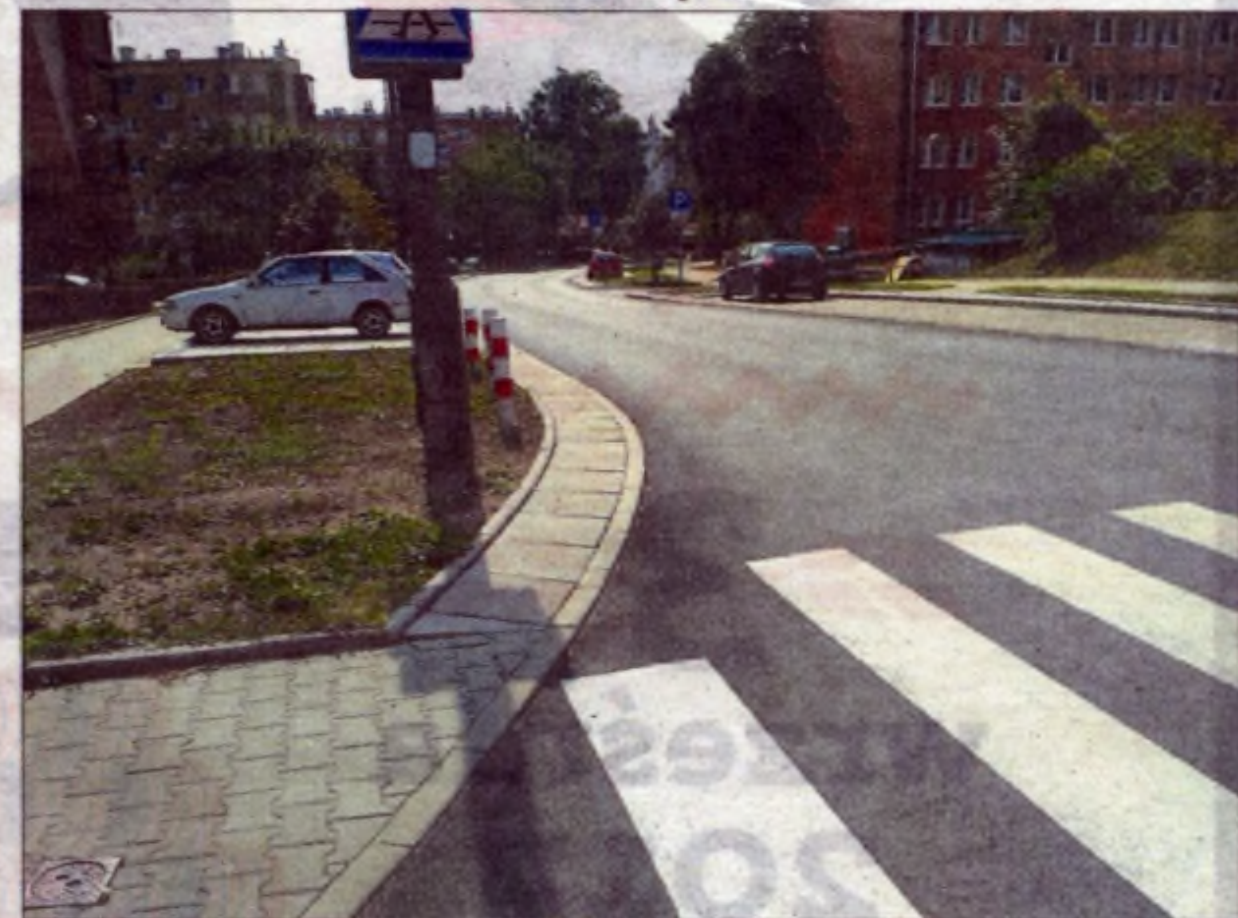
Ulica Kruszwicka po remoncie.
