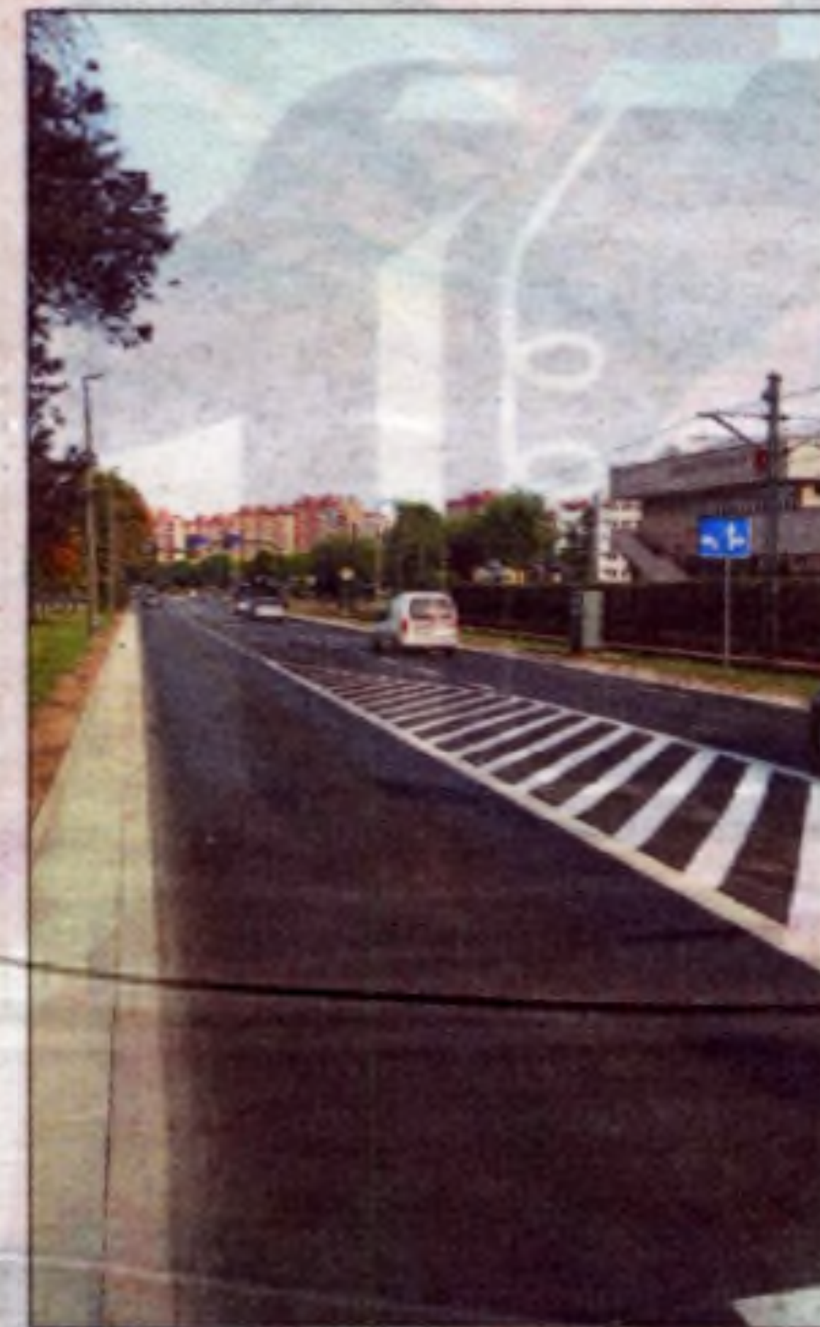
Ulica ks. Jancarza po remoncie.
