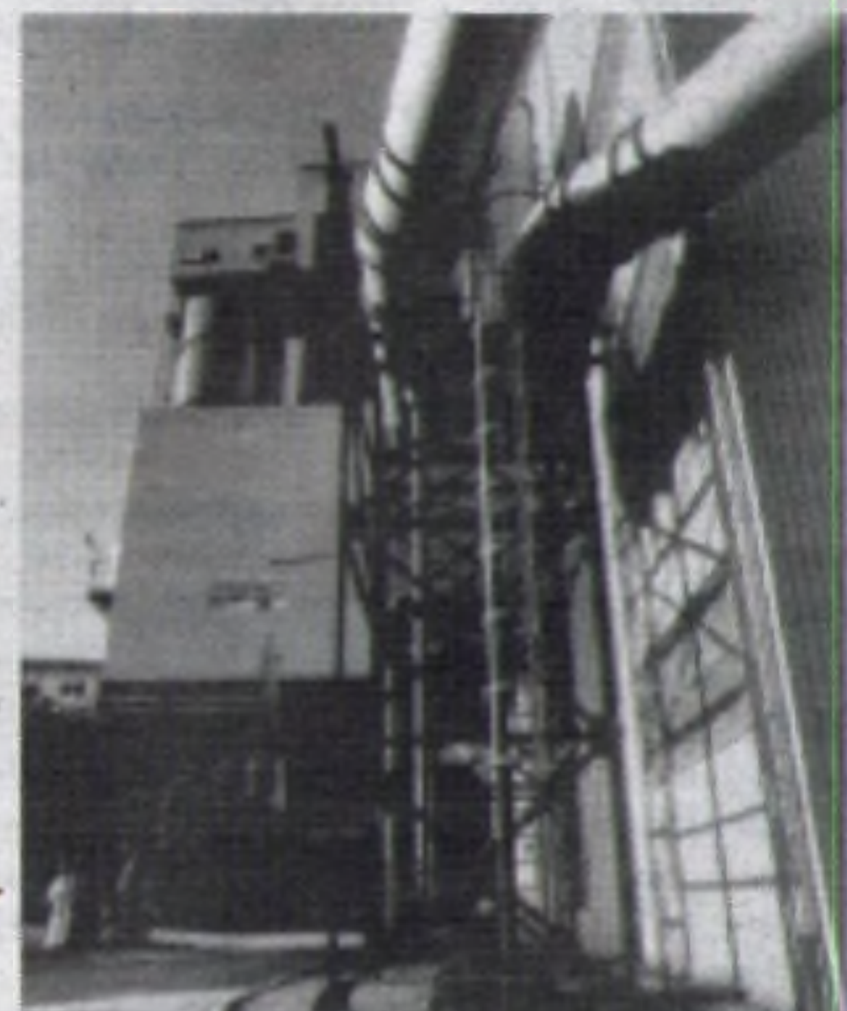
...i wykonali instalację odsiarczania surowki.
