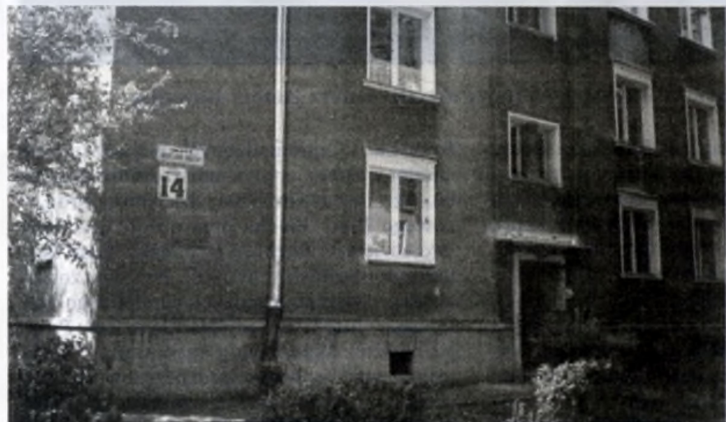
Blok nr 14 w os. Wandy wyróżnia się wśród okolicznych budynków pamiątkową tablicą. To tutaj zamieszkali pierwsi mieszkańcy nowego miasta.
