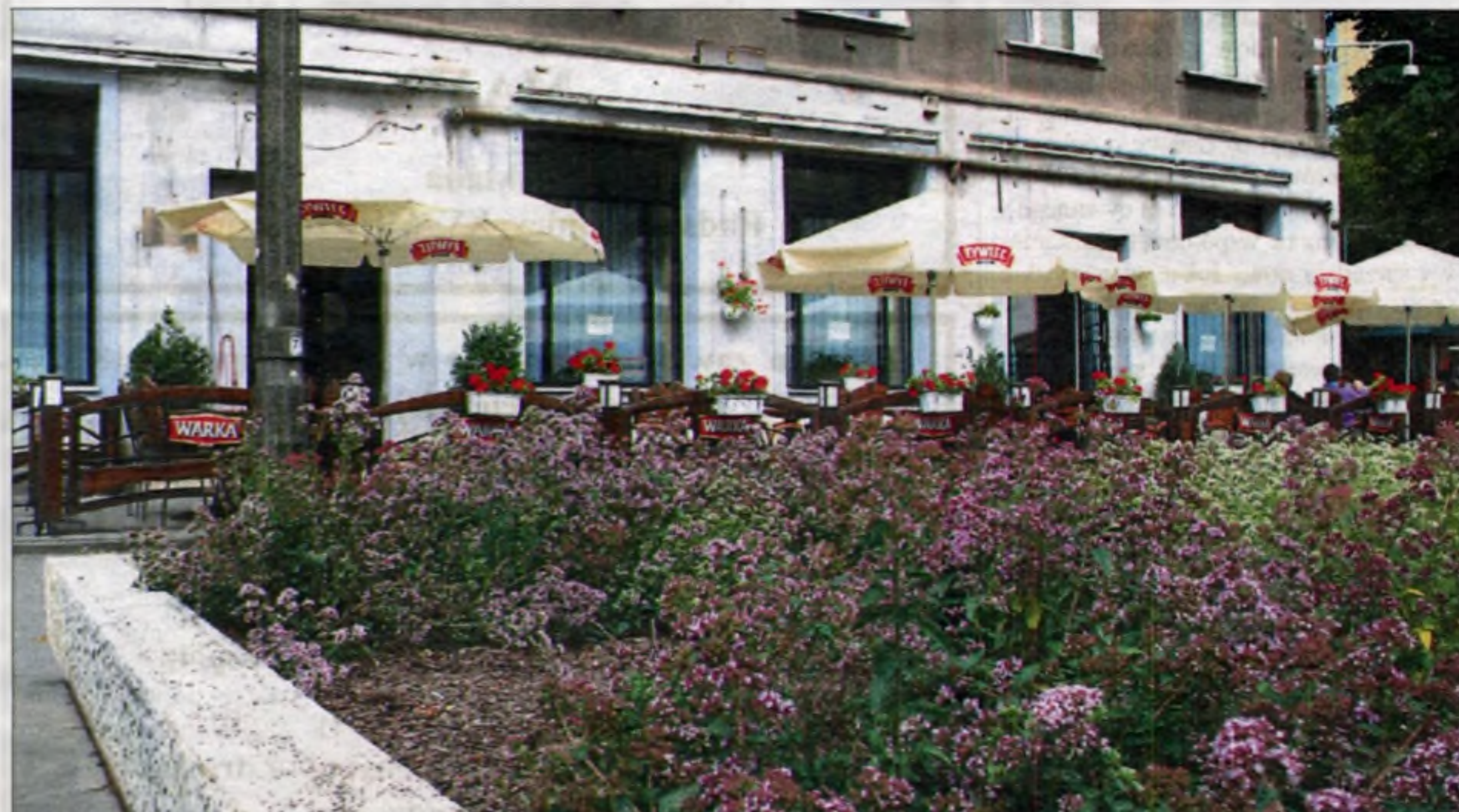
Na razie w „Stylowej” wymieniono okna i drzwi. Teraz czas na odnowienie elewacji.
