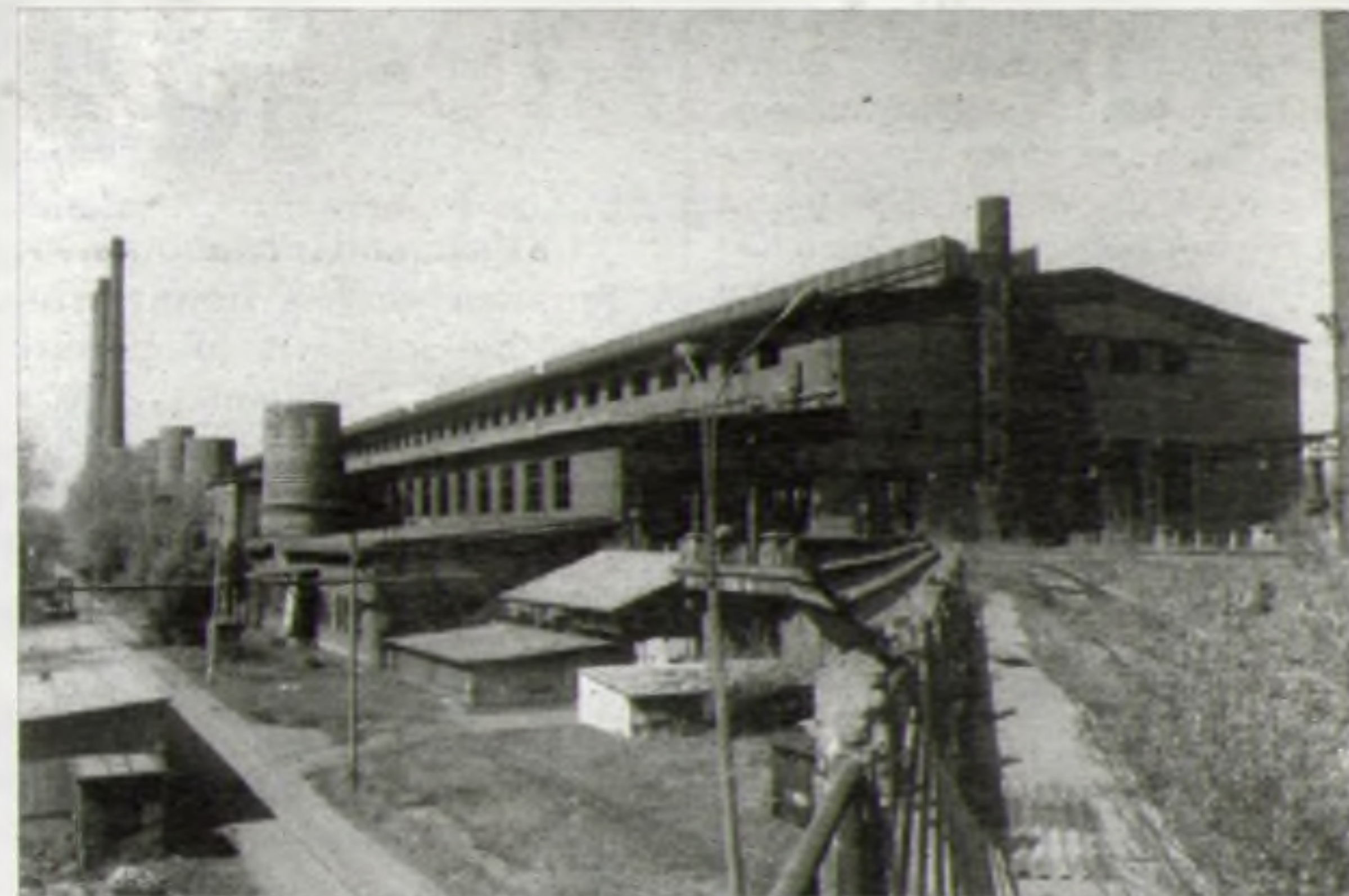
Wyburzenie starej hali stalowni martenowskiej pozwoliłoby na odzyskanie 8 hektarów terenu. Wprowadzenie tu nowych firm mogłoby być symbolem kierunku przemian, zapisanych w programie restrukturyzacji majątkowej HTS.
