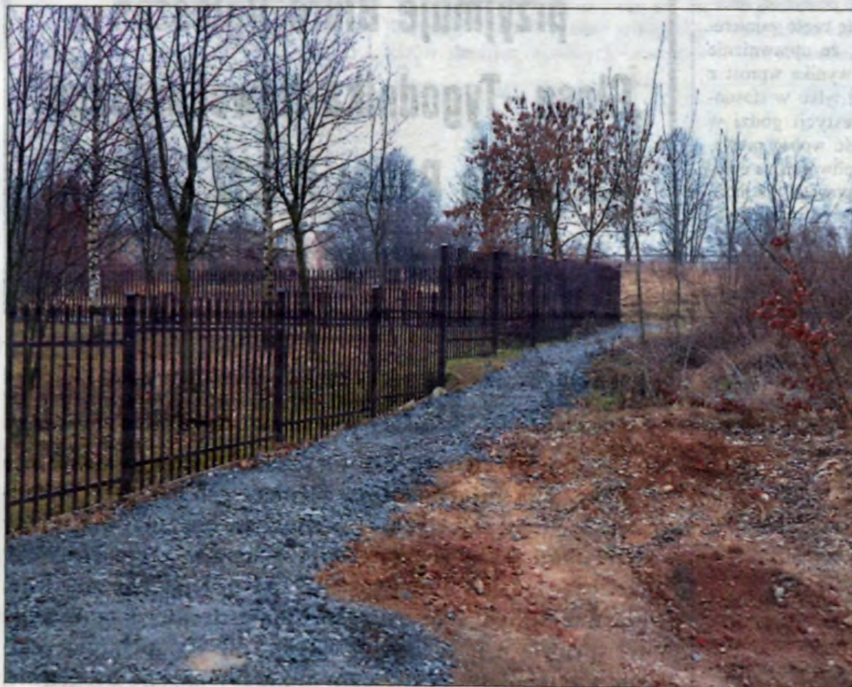
Mieszkańcy wykonali we własnym zakresie prowizoryczne przejście.
