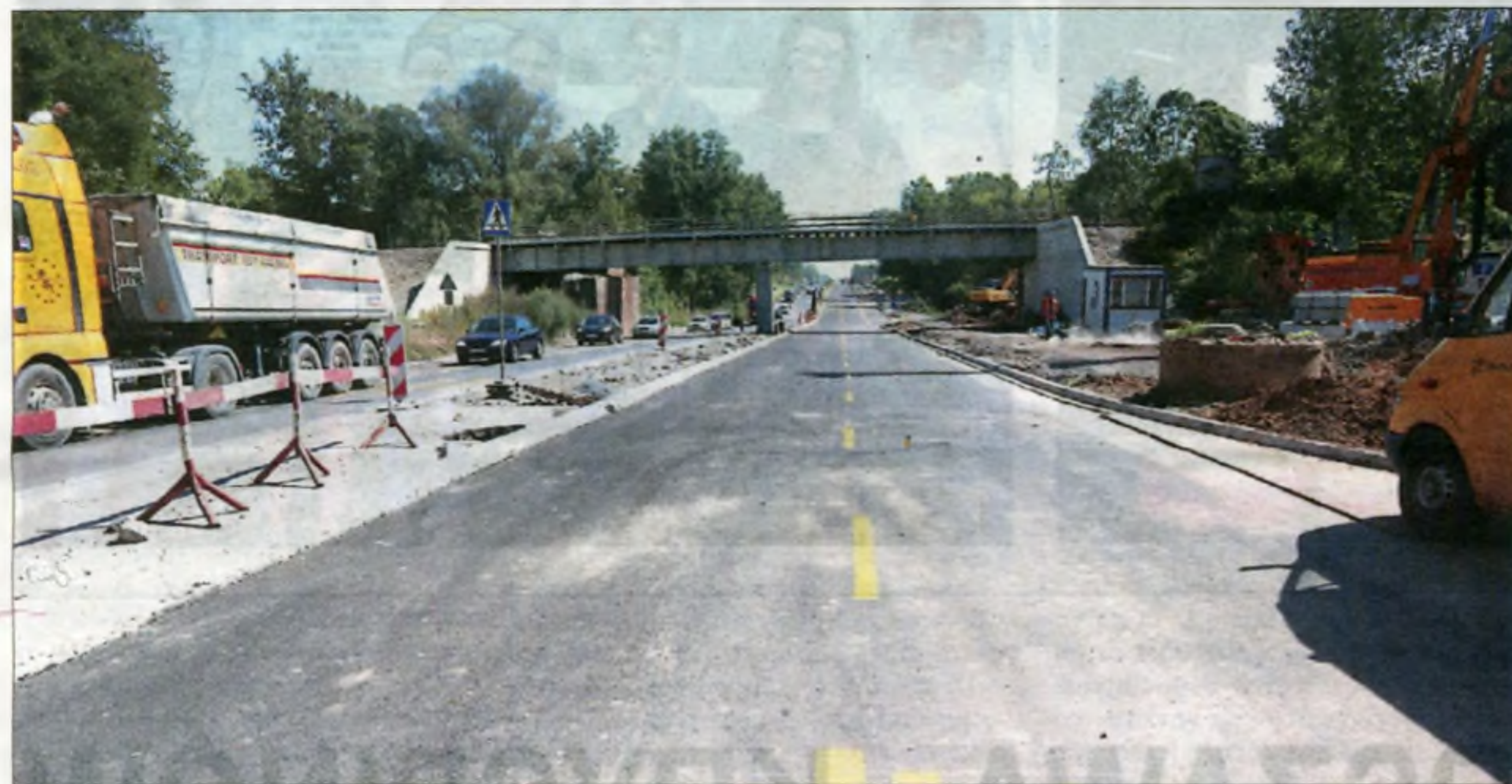
Tuż przed otwarciem nowej jezdni.
