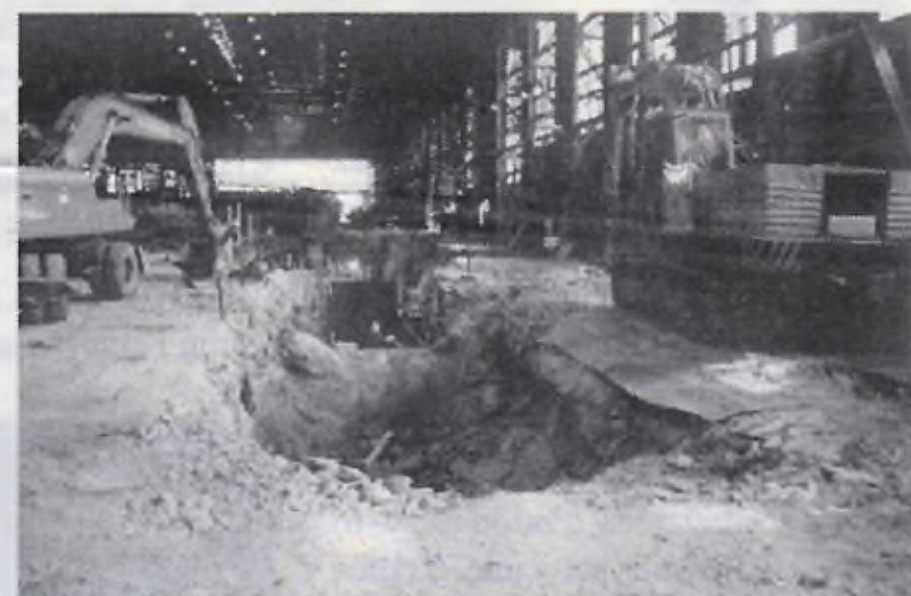
Wykopy pod fundamenty rozpoczęto na początku października br.
