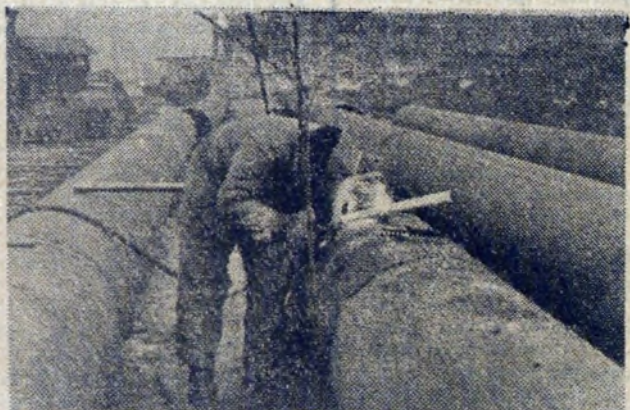
Zakładanie rurociągu z kombinatu do miasta
