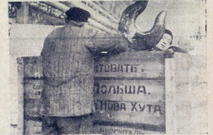
Rozpakowywanie importowanych ze ZSRR urządzeń wentylacyjnych przeznaczonych dla Walcowni Zimnej HiL.
