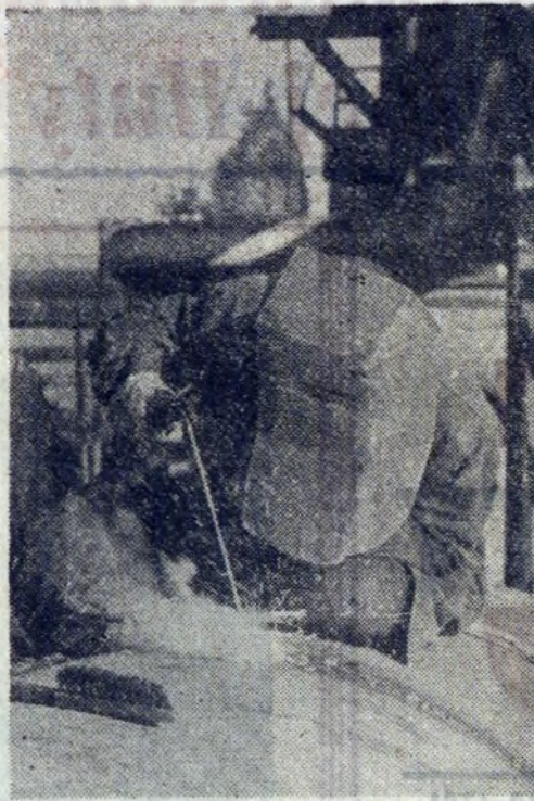
Prace przy montowaniu rurociągu wielkiego pieca w HIL.
